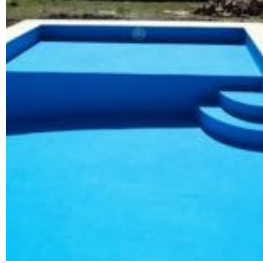
PINTURA DE ALBERCAS
