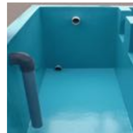
PINTURA DE CISTERNAS
