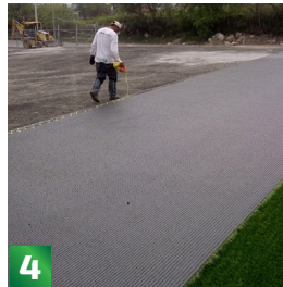
4 Preparación de la unión
